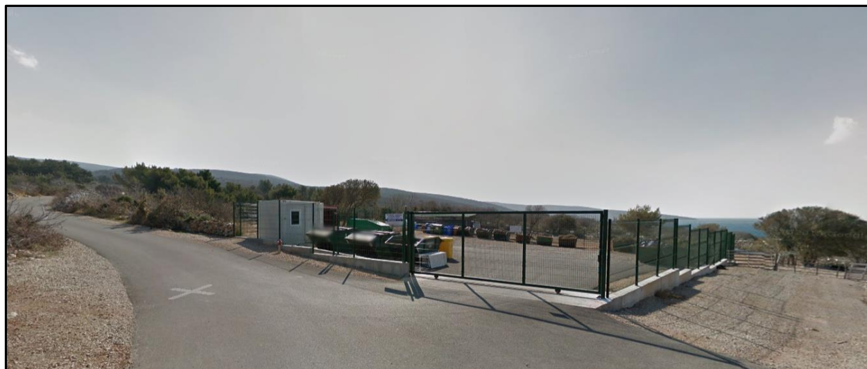
Slika 7: Pogled na reciklažno dvorište Punat
