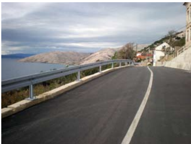
čelične zaštitne ograde (odbojnici) uz cestu na novo napravljenim proširenjima ceste u Staroj Baški
