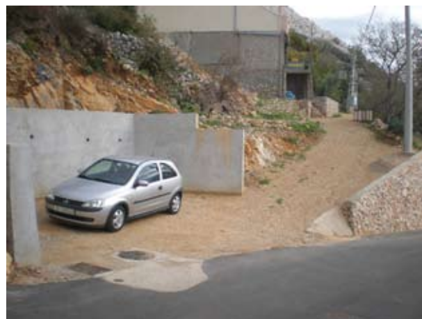
armirano-betonski zidovi, kameni zid, plato parkinga uz prometnicu, prilazna rampa u Staroj Baški,
